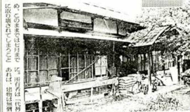
太平洋戦争末期、松代大本営建設にともない、朝鮮人慰安婦が働かされていた建物 ＝長野市松代町で
